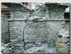
Edificio A, lato esterno, sud. Si noti il coronamento a "gola egizia", sottolineato da una fascia di lastre marcapiano, con funzione di gocciolatoio. L'arco è stato tamponato, probabilmente in concomitanza con l'apertura di quello nuovo, sul lato ovest.
