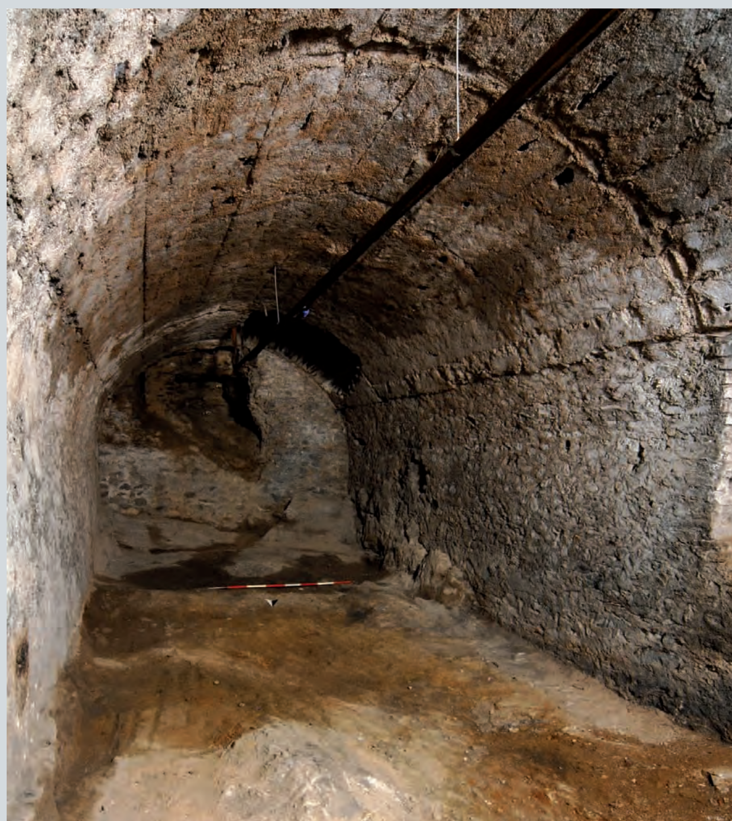
Castello: volta di uno degli ambienti di sostruzione di epoca romana
