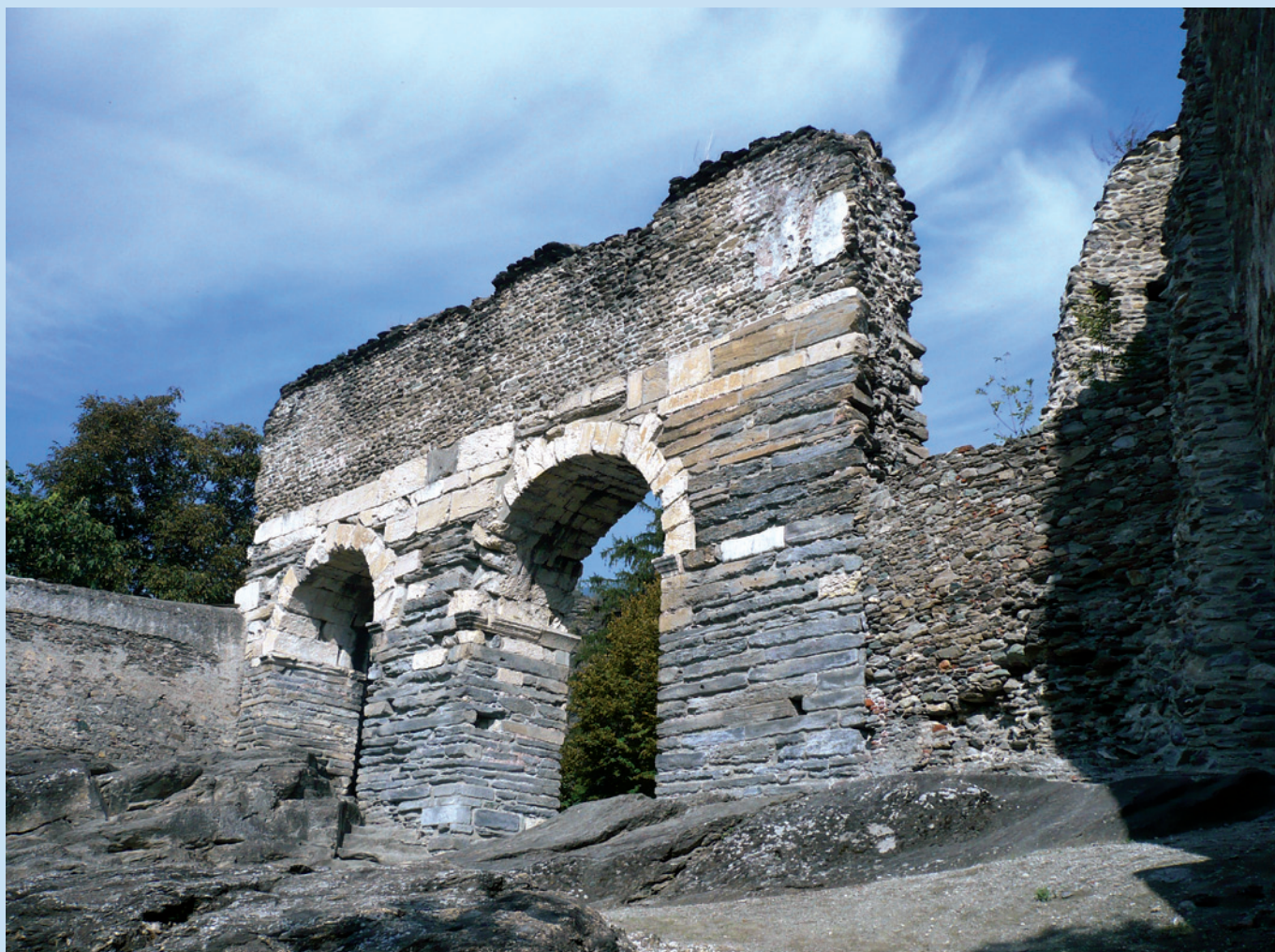
Acquedotto da Sud-Est.
