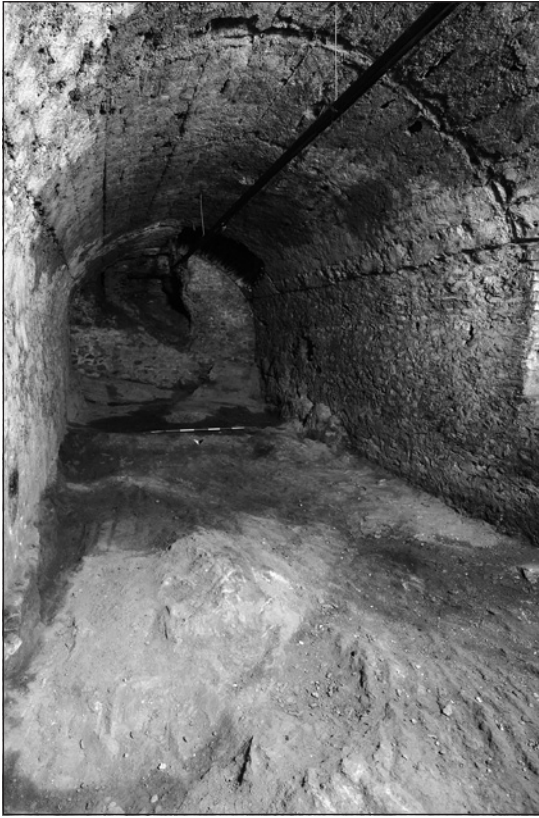
Fig. 5 - Susa, Castello. Ambiente voltato di sostruzione del Praetorium (foto G. Lovera).
