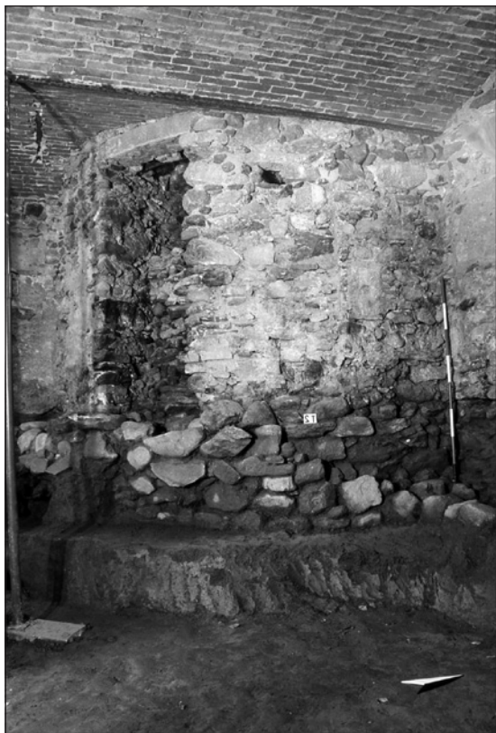
Fig. 11 - Chiusa S. Michele, cappella di S. Giuseppe. Struttura a pianta quadrata, in pietrame legato da malta terrosa, compresa tra quattro torri circolari (particolare).
