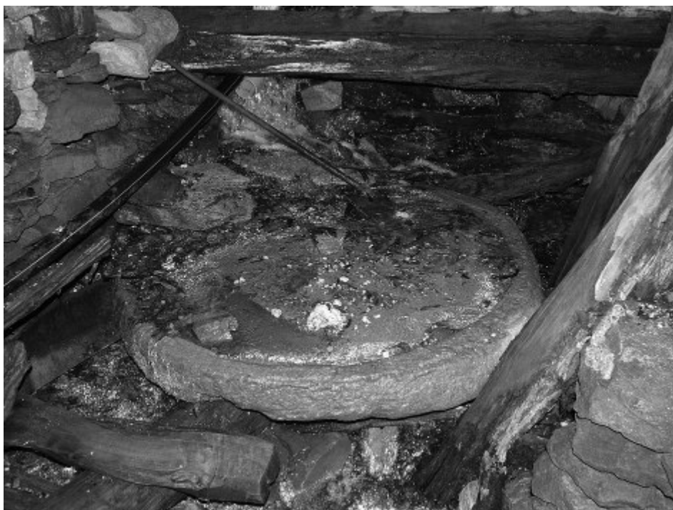
Fig. 47) Vista della camera delle acque del Mulino di Frenée.
