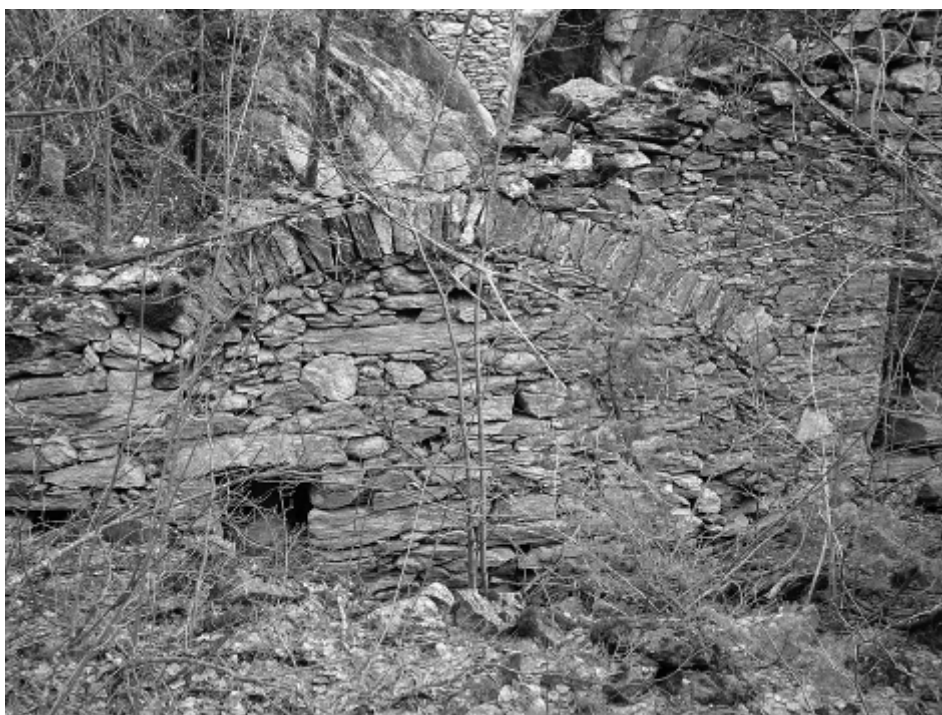
Fig. 50) Dettaglio della muratura del primo opificio a monte, a Oulme.
