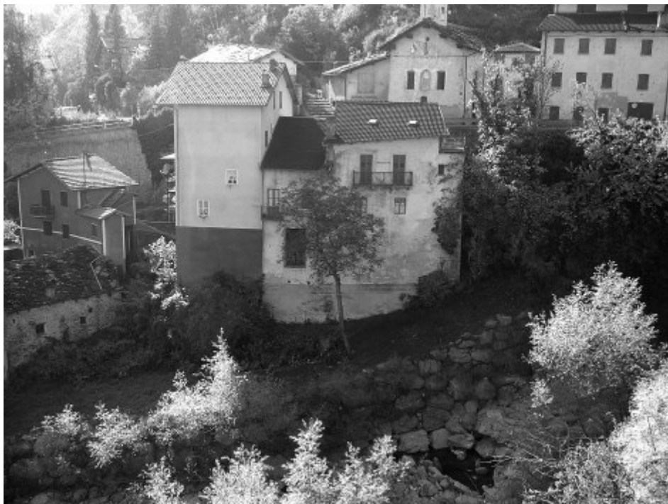
Fig. 15) Lungo Via Molini, a Exilles, si trovavano alcuni opifici idraulici, tra cui una segheria idraulica, di cui resta l'edificio e gli ingranaggi, anche se non più mossi dall'energia dell'acqua.
