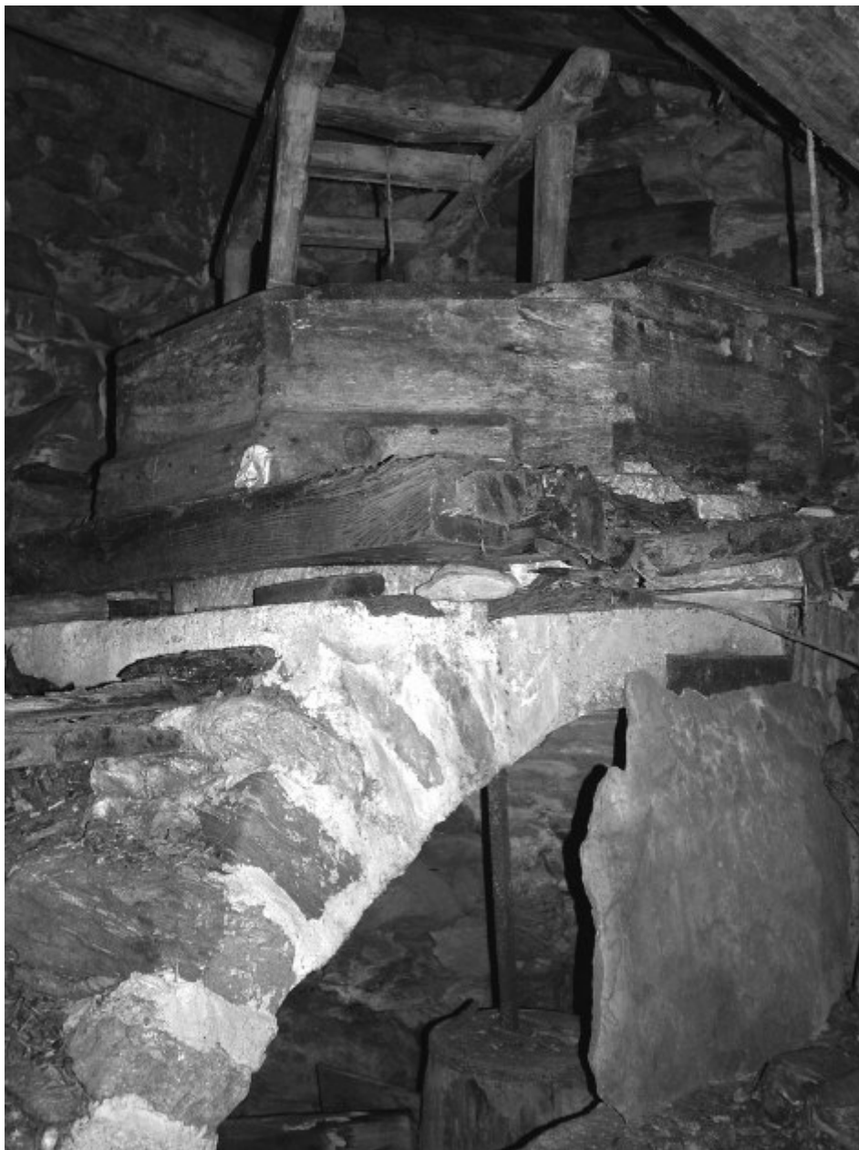
Fig. 7) Mulini di San Colombano, a Exilles. Si noti come la ruota, nel caso del mulino a ruota orizzontale, debba collocarsi sotto l'edificio, nella camera delle acque. In questo caso si tratta di un vano comunicante con l'ambiente superiore, per permettere l'accesso alla ruota in caso di manutenzione.
