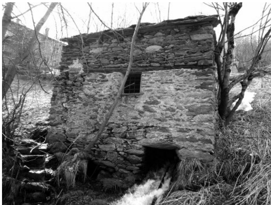
Fig. 9) Dettaglio della fuga delle acque di un piccolo mulino a ruota orizzontale, Borgata Eclause, a Salbertrand.
