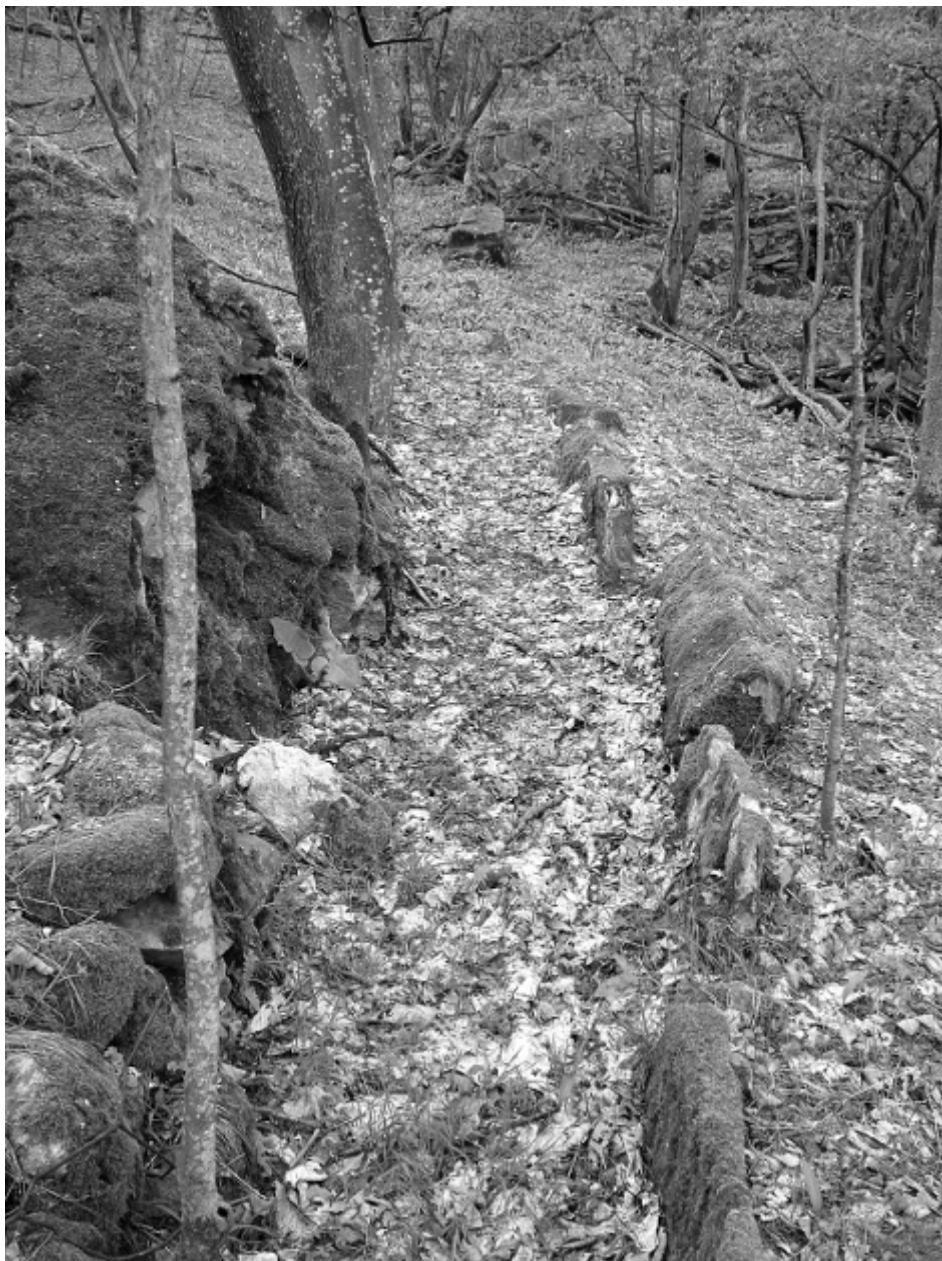
Fig. 4) Bialèra rinforzata con pietre piatte di taglio, presso i Mulini Sibille-Charbon, a Chiomonte.
