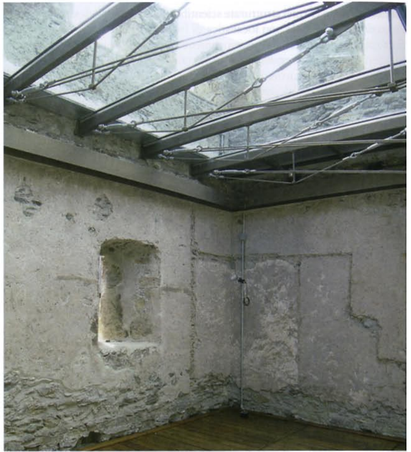
(FIG. 11) Oulx, torre delfinale, interno dell'ultimo livello con la nuova copertura
