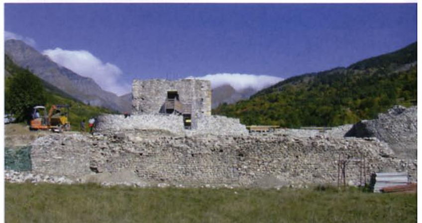
(FIG. 13) Bardonecchia, parco archeologico della Tur d'Amun, fasi del cantiere di scavo e restauro (2006)
