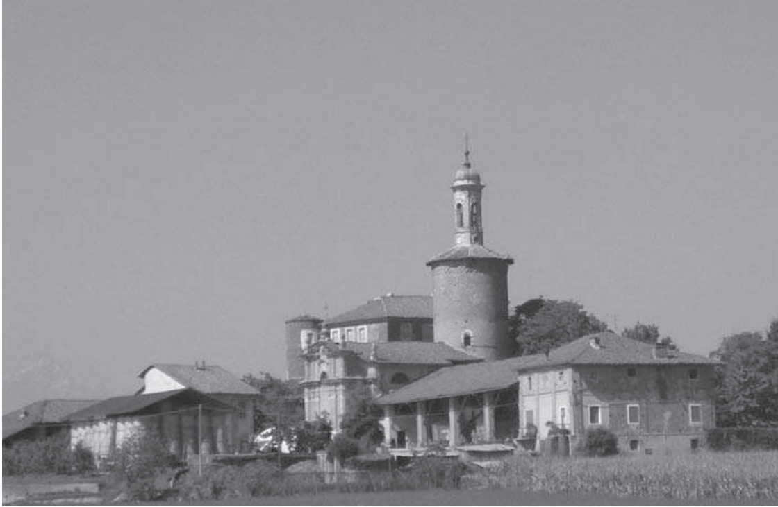
Fig. 3 - Salza di Marene (Cn), vista del complesso con la torre centrale cilindrica.
