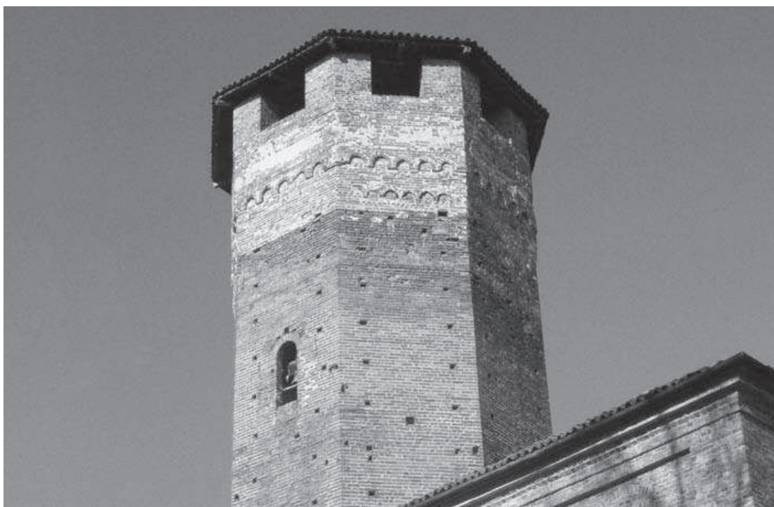
Fig. 9 - Sommariva Bosco (Cn), coronamento della torre maestra centrale.
