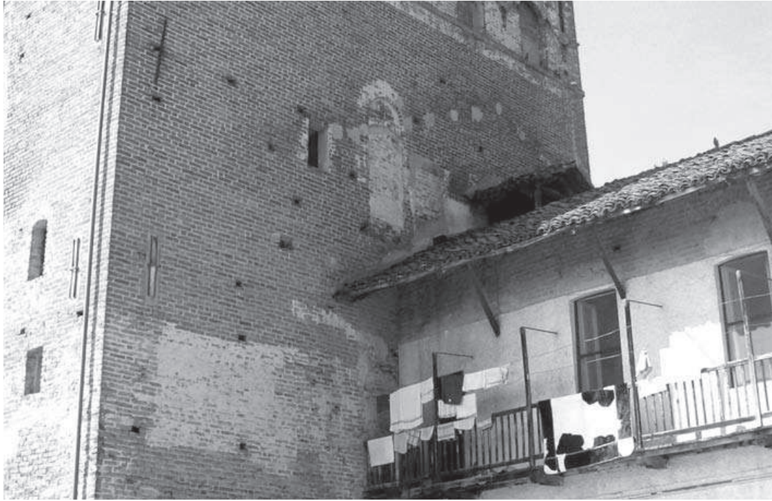
Fig. 5b - La Gorra, dettaglio dell'innesto della manica rurale, con palinsesto murario dei precedenti assetti sulla tessitura muraria della casa-forte.
