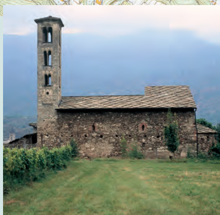
Il fianco meridionale della chiesa romanica di San Saturnino, a navata unica absidata e campanile innestato sull'angolo sud-occidentale.
